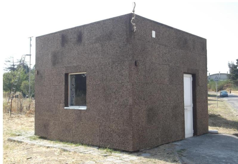
Aglomerado de cortiça sobre a parede existente
